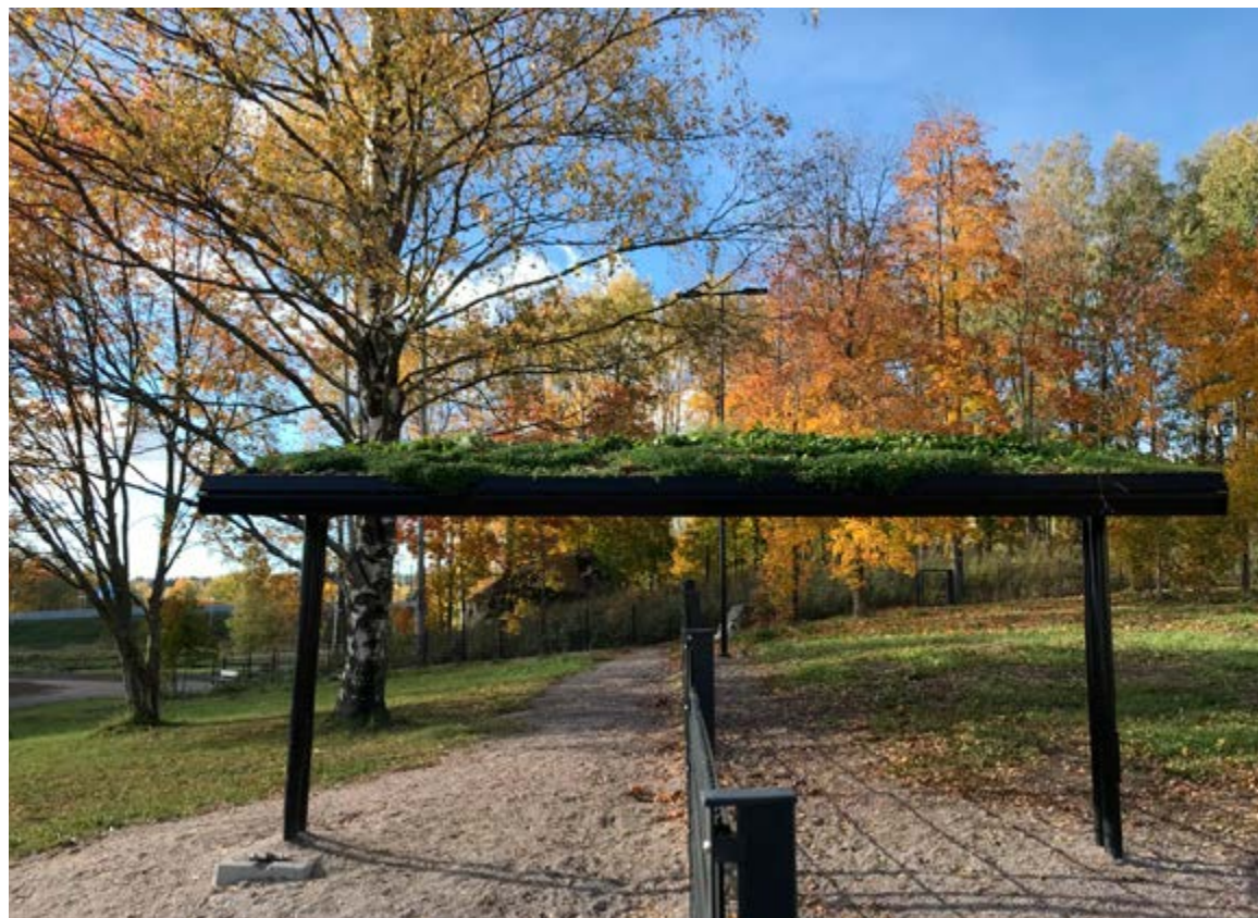
Kaupungin omassa rakentamisessa kasvikatto toteutetaan pääsääntöisesti kaikkiin uusiin kylmiin rakennuksiin. Kuvassa Suomen ensimmäinen koirapuistoon toteutettu kasvikatto Hakunilassa. Kuvaaja: Taina Suonio
