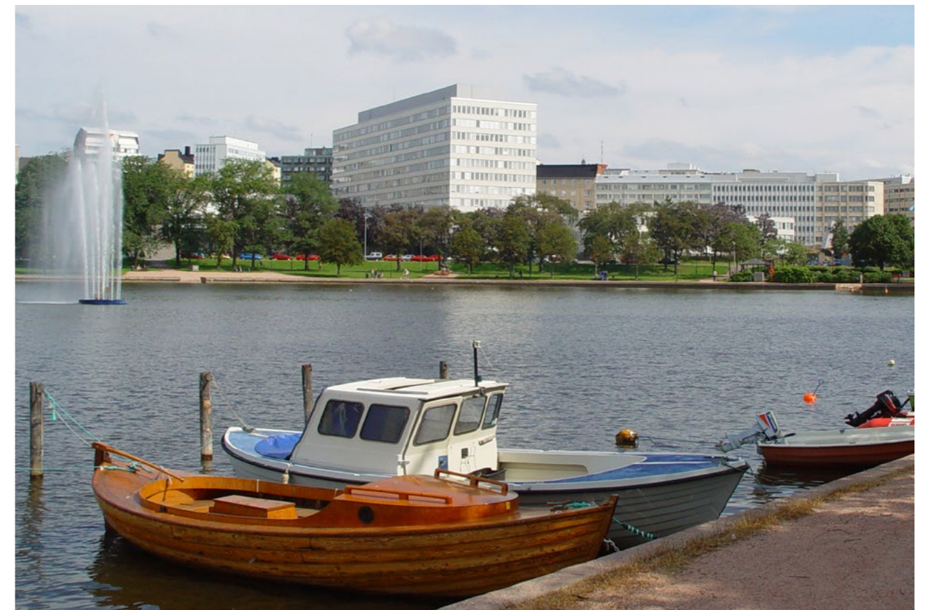
Helsingissä yhtenä energiatehokkuuskumppanuuden pilottikohteena toimi Kallion virastotalo (valkoinen rakennus), jossa työskentelee mm. Sosiaali- ja terveystoimialan henkilöstöä.
